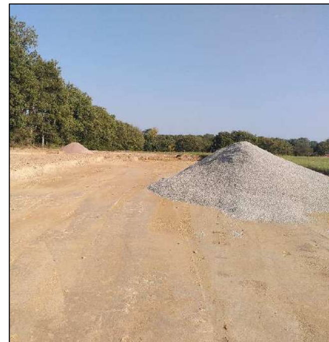
Photo 8: stock de matériaux sur le chantier - septembre 2021
