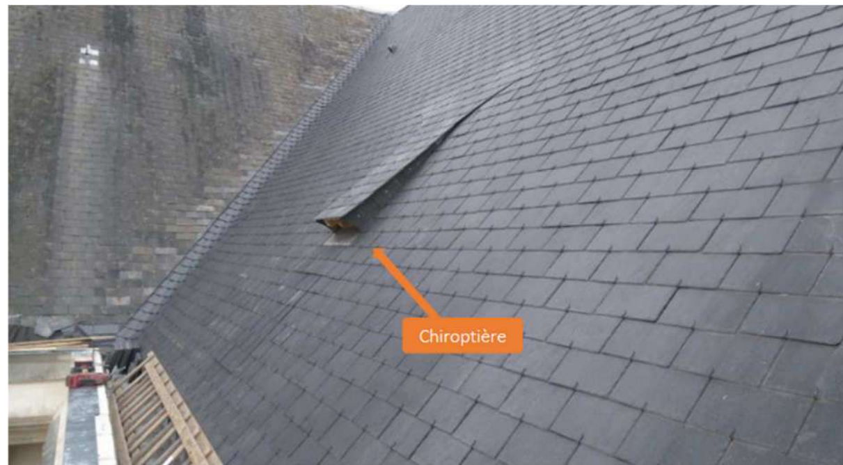
Aménagement d'un accès aux combles pour une colonie de mise-bas de chauves-souris
