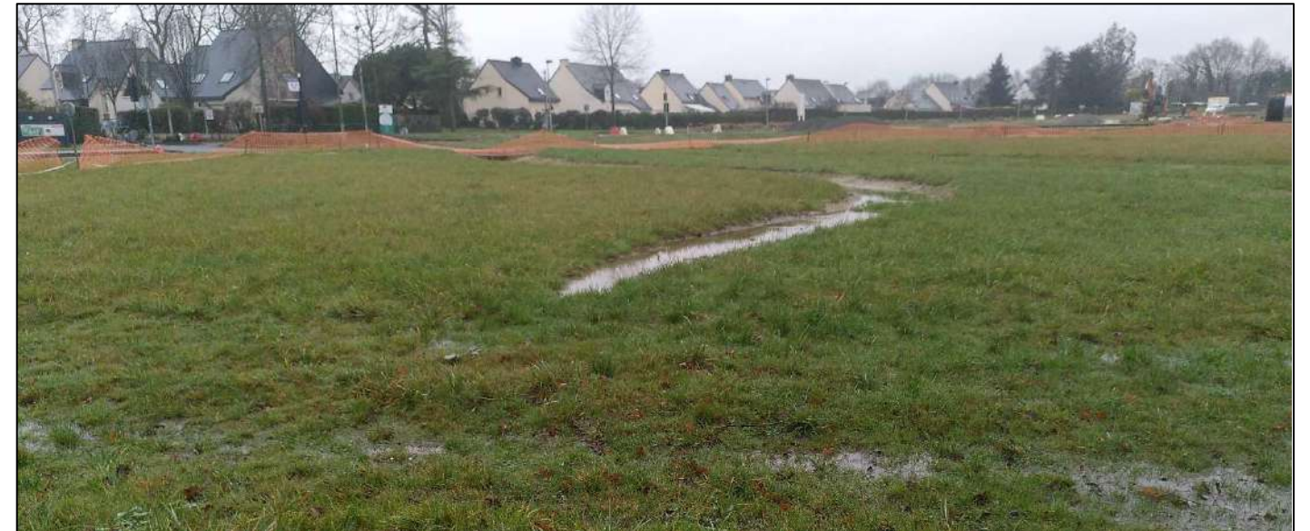
Photo 6: vue de la noue – Janvier 2022
