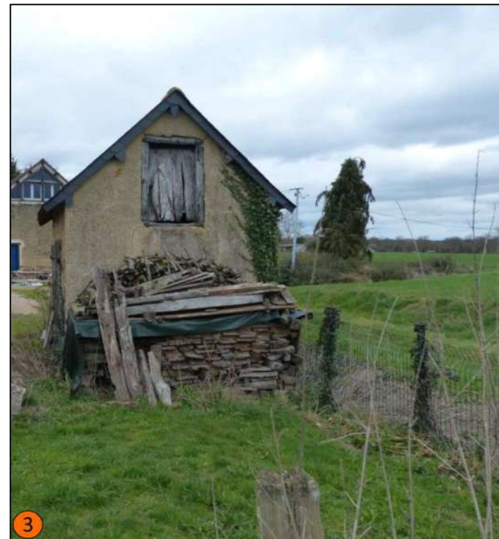
Photo 3 : Hameau de la Touraudière - site de la Touraudière - IAOSENN 2017
